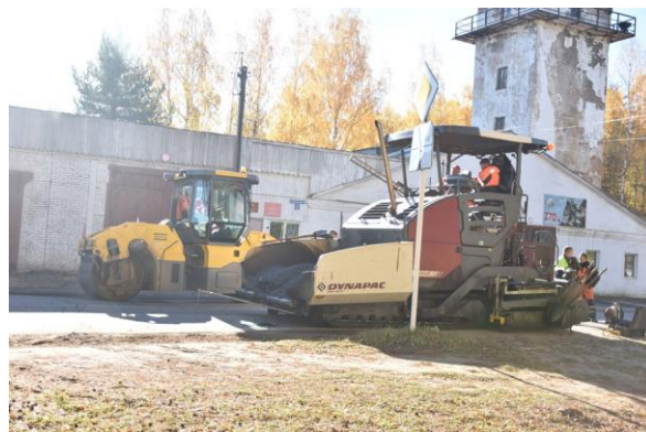
Фото 25. Выполнение работ по замене асфальтобетонного покрытия проезжей части и тротуара на ул. Стекольщикова в п. Чагода.
