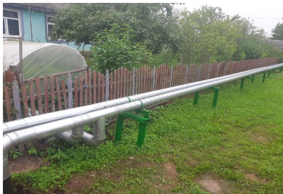
Фото 19. Участок тепловой сети в п. Борисово, ул. Школьная
