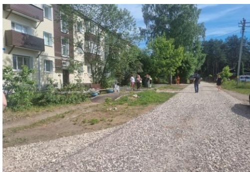
Фото 22. Благоустройство придомовой территории п. Чагода, ул. Мира, д.29
