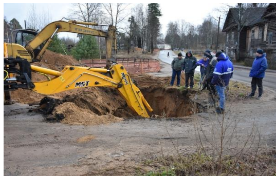
Фото 23. Реконструкция магистральных водоводов и закольцовка водозаборов п. Чагода
