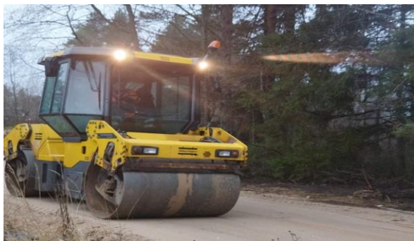
Фото 24. Выполнение работ по устройству песчано-гравийного покрытия на ул. Береговая в п. Чагода.
