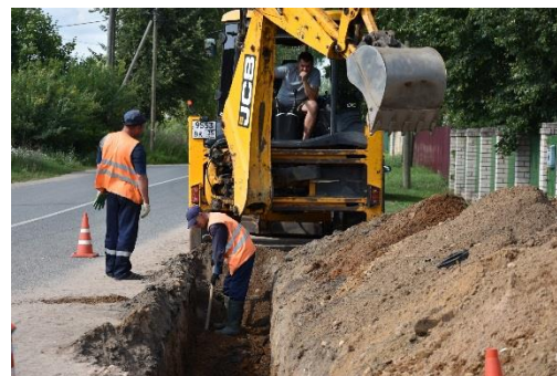
Фото 32. Работа по укладке магистрального газопровода и обустройству газопроводов-отводов
