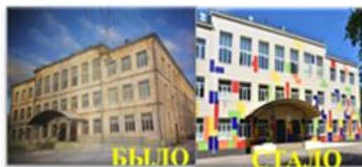
Фото 10. Здание ЧСОШ до и после капитального ремонта
