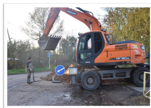
Фото 26. Замена водопроводных сетей в мкр.ЛПХ п. Чагода
