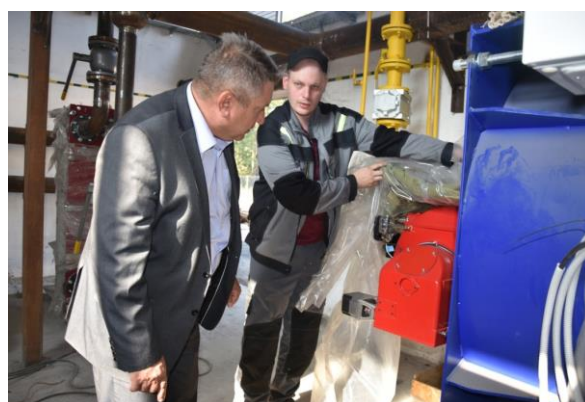
Фото 24. Во время капитального ремонта котельной в микрорайоне Агропромхимия в п.
