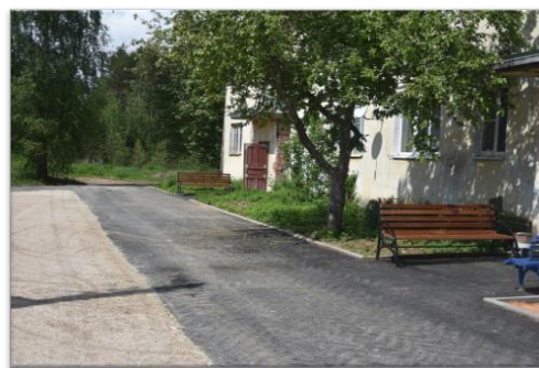
Фото 33. Благоустройство дворовой территории по ул. Авиации в п. Сазоново
