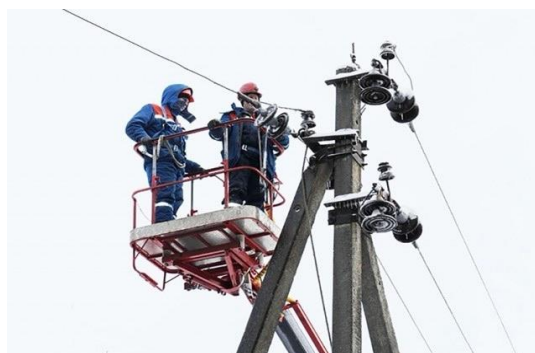
Фото 34. Восстановительные работы на линиях электропередач
