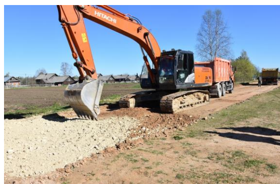
Фото 37. Подготовка основания улицы Набережная, с. Покровское
