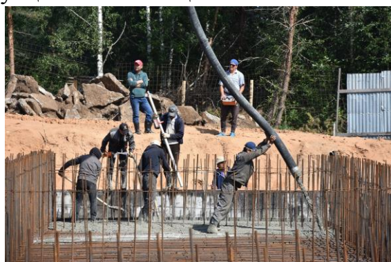
Фото 29. Устройство основания резервуара для приемки бытовых отходов очистных
