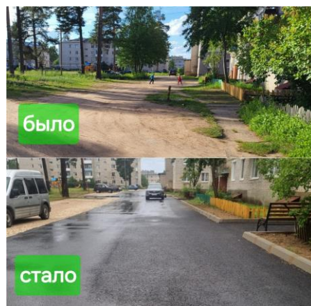
Фото 35. Благоустройство дворовых территорий
