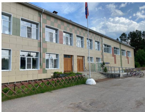
Фото 11. Капитальный ремонт Сазоновской средней общеобразовательной школы
