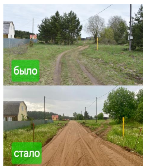
Фото 38. Ремонт участка автомобильной дороги ул. Космонавтики, п. Сазоново
