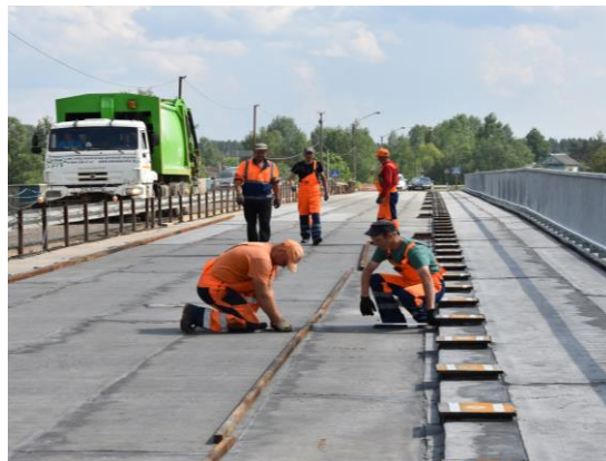
Фото 39. Ремонт моста через реку Чагодоца
