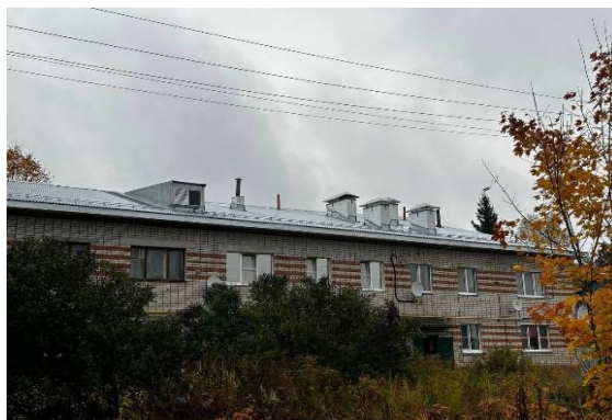
Фото 32. Отремонтированная крыша многоквартирного дома в п. Первомайский
